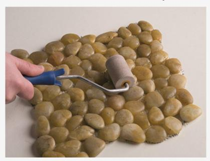
Wichtig: Überprüfen Sie vor dem Verlegen die Farbvariation jeder Fliese und verwenden Sie auch Fliesen aus verschiedenen Schachteln, um eine größere Homogenität zu erreichen. Zu diesem Zweck ist es sinnvoll, stets 5% mehr Material zu bestellen, als benötigt wird.
