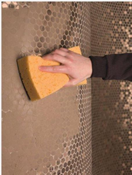
Benutzen Sie einen feuchten Schwamm, um das überschüssige Material nach der Verlegung zu reinigen. Es ist wichtig, dass es nicht austrocknet. Falls es dennoch austrocknet, können Zementlösemittel oder Lösemittel für Epoxidfugen (nicht für Stein geeignet) benutzt werden.
