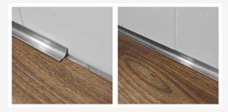
Lassen Sie eine Dehnungsfuge von 10 mm, füllen Sie sie mit Silikon aus und decken Sie sie mit Klebeband ab.
