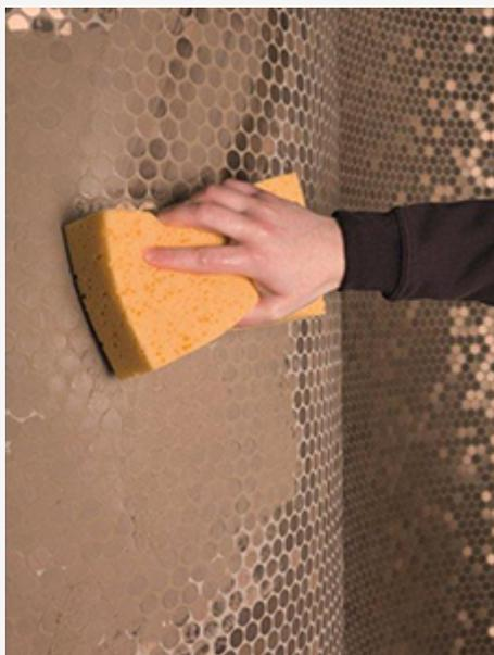
Utiliser une éponge humide pour nettoyer le matériel qui déborde, une fois la pose terminée. Il est important de ne pas laisser sécher le résidu. Au cas où le matériel sèche, utiliser du décapant pour ciment ou pour joints époxy (non adapté à la pierre).
