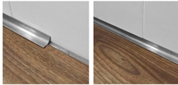
Laisser 10 mm de joint d'expansion, remplir de silicone et couvrir d'un moulage écossais.
