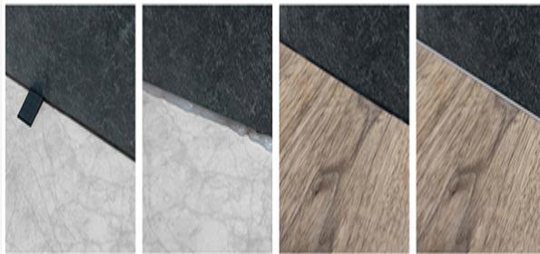
Placez les tuiles murales à une hauteur de 6mm. Placez également l'articulation périphérique de 10 mm entre le mur et C&F. Remplissez l'espace avec du silicone et placez la planche sous la tuile. Rejoindre.
