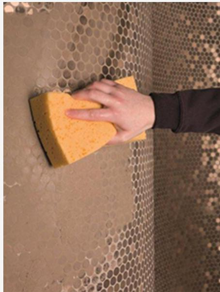
Usare una spugna umida per eliminare il materiale in eccesso dopo l'installazione. È importante non lasciarlo asciugare. Nel caso in cui il materiale si asciughi, utilizzare dei disincrostanti per cemento o di stuccatura epossidica.
