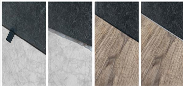
Posare le piastrelle della parete ad un'altezza di 6 mm. Collocare anche un giunto perimetrale di 10 mm tra la parete e C&F. Riempire lo spazio con del silicone e collocare l'asse sotto la piastrella. Riempire le fughe
