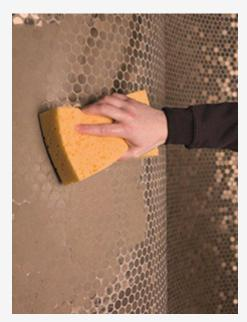
Utilizar una esponja húmeda para limpiar el material sobrante tras la colocación. Es importante no dejarlo secar. En caso de que el material se seque, utilizar desincrustantes para cemento o para pastas de rejuntar epoxy (no apto para piedra).
