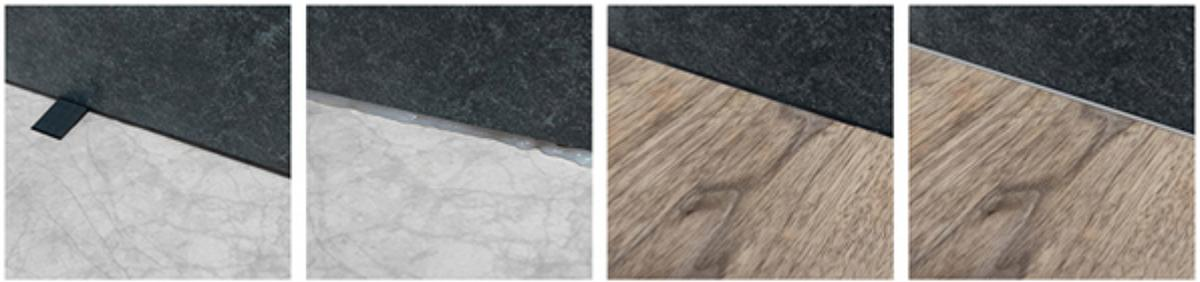
Coloque los azulejos de la pared a una altura de 6mm. Coloque también junta perimetral de 10 mm. entre la pared y C&F. Rellenar el hueco con silicona y colocar la tabla bajo el azulejo. Rejuntar.
