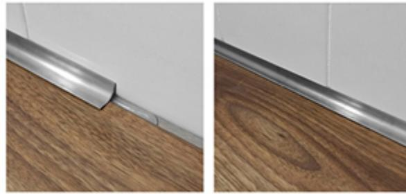
Dejar 10mm. de junta de expansión, rellenar con silicona y cubrir con una moldura escocia.
